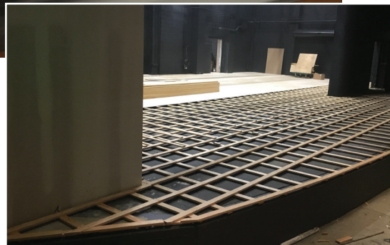
Projet de plancher de scène de la Kennesaw State University avec Harlequin WoodSpring et Harlequin Cascade.
